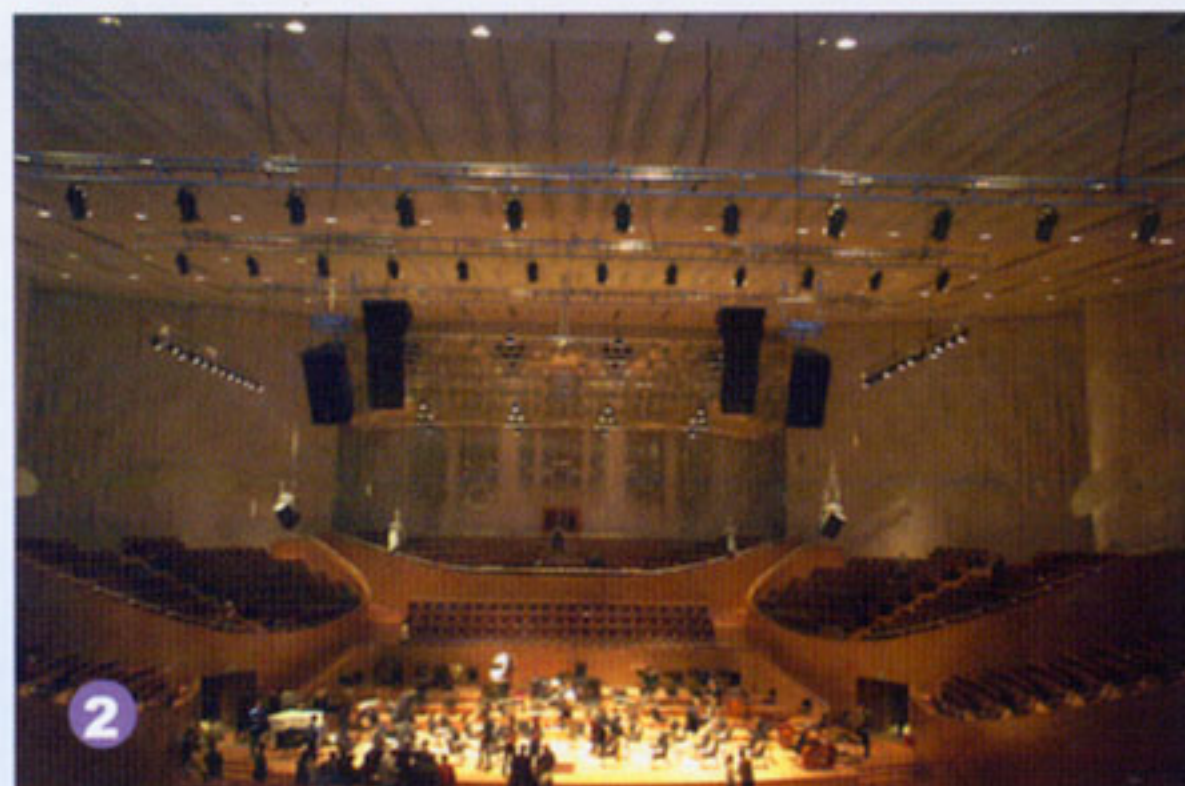
图示中央左右两侧为 VT4888 线阵列音箱，其余为投射各坐席区的 AE 系列音箱
