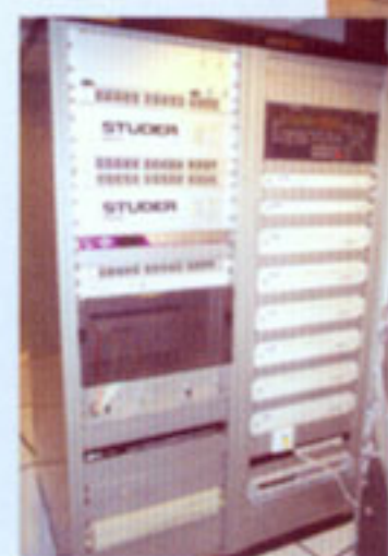
图1a 舞台信号传送机柜 图1b 以VISTA8数字调音台为核心的扩声主控机房
