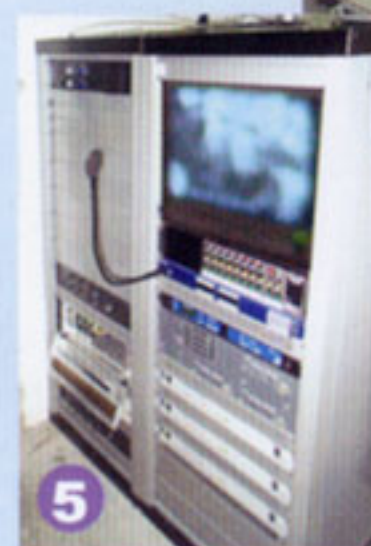
▲ 功放机柜左侧为 Cobra Net 网络部分
