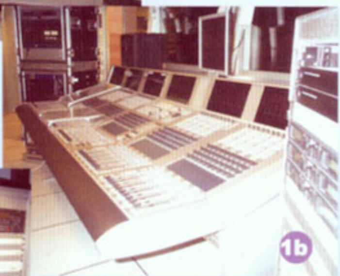
图1a 舞台信号传送机柜 图1b 以VISTA8数字调音台为核心的扩声主控机房
