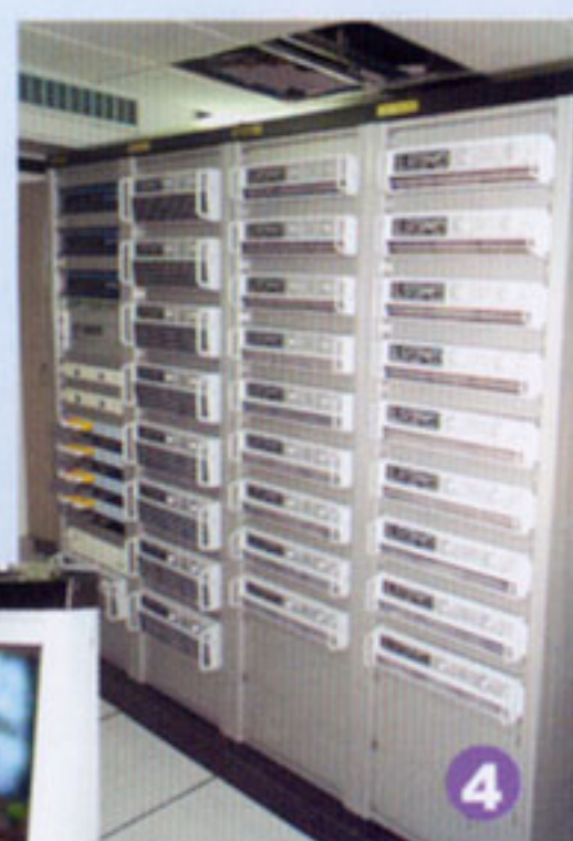
▲ 功放机柜左侧为 Cobra Net 网络部分
